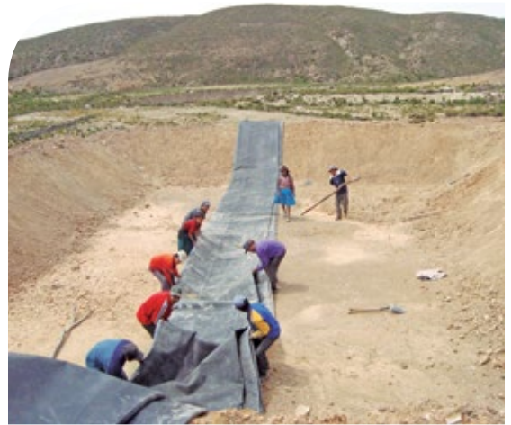
Foto: Construcción de atajado en Cotagaita.
